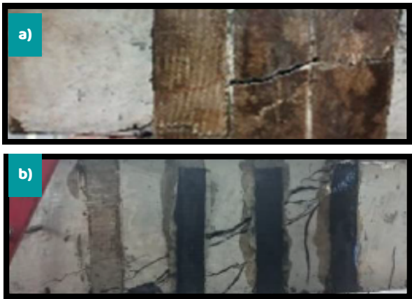
Fig.2- Vigas reforçadas. a) fibra natural; b) manta de carbono
